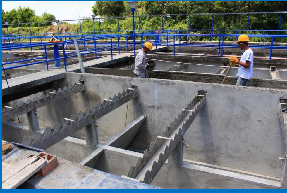
Obra civil para la reparación de superficie de muros y estructuras de soporte de módulos de sedimentación de planta de potabilización N° 2
